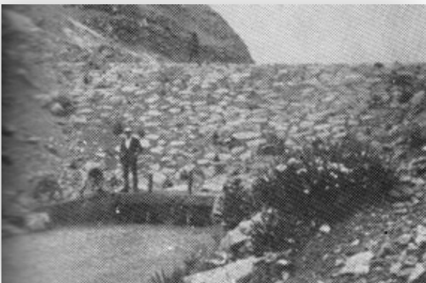
Conductos de descarga cubiertos y dique reconstituido. Foto 3
