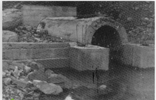
Detalle de la construcción de un conducto cubierto. Foto 5
