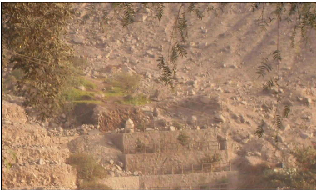
Figura 19: Muros de contención en la parte baja de la quebrada colindante a la residencial El Cuadro. El muro evita que las rocas sueltas, producto del flujo de detritos, alcancen la parte baja (carretera central).
