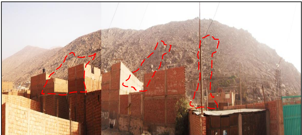
Figura 21: Caída de rocas en las inmediaciones de la Asoc. Viv. El Huáscar. Margen izquierda del río Rímac.
